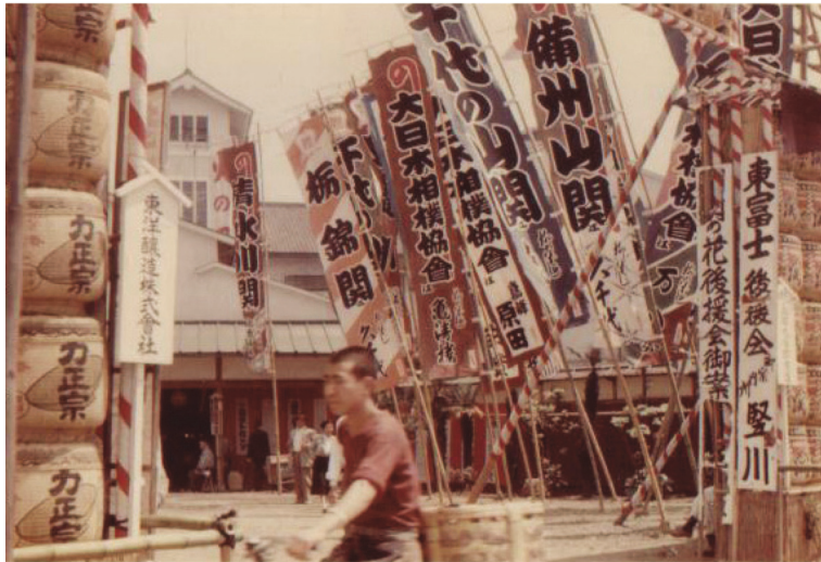
写真1 昭和29年：蔵前国技館 相撲案内所側入り口 ( http://www.k2.dion.ne.jp/~shiki/dion.shashin.htm より、転載フリー写真)
