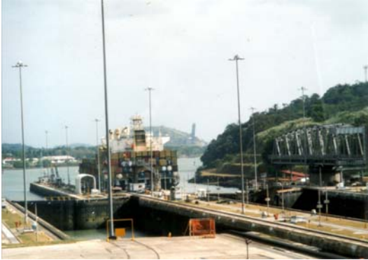
閘門から太平洋へ出ていく大型貨物船
